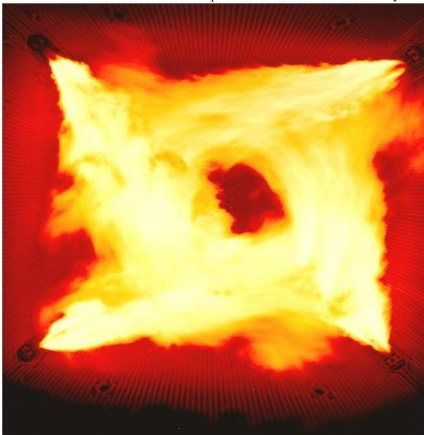
Рис. 3. Фотография топки котла мощностью 200 МВт, оснащенного 4 прямоточными ПТС, в процессе плазменной растопки (вид сверху).
